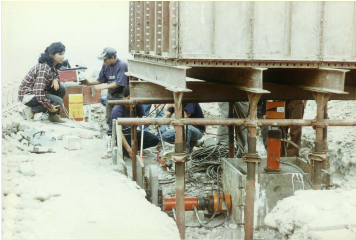
Foto N°1 Realizando el ensayo de Corte Directo In-situ, en la corona del talud
