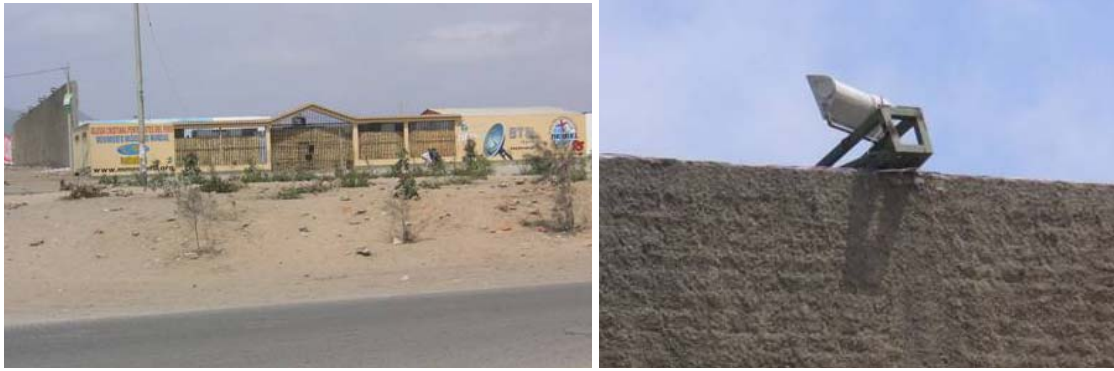
Figura 10. Iglesia colapsada en Villa El Salvador 3 días después del sismo. Izquierda: Muro de fachada demolido. Derecha: detalle de apoyo de tijeral en muro exterior.
